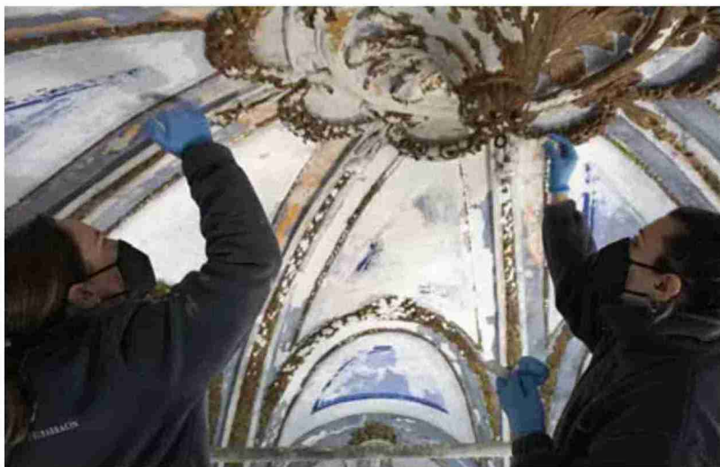
Trabajos de restauración de la ornamentación de la deteriorada cúpula de la ermita de Loreto de Fortanete
